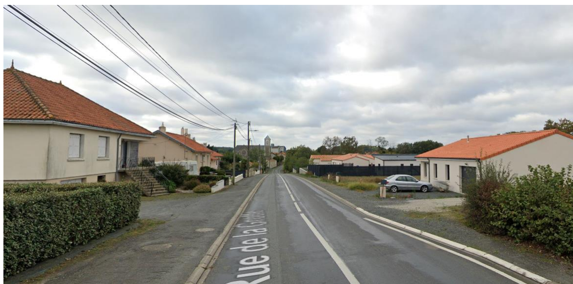
Figure 23 : Vue sur l'église et l'ancien site agro-industriel depuis l'entrée nord du bourg (Source : Google street view)
